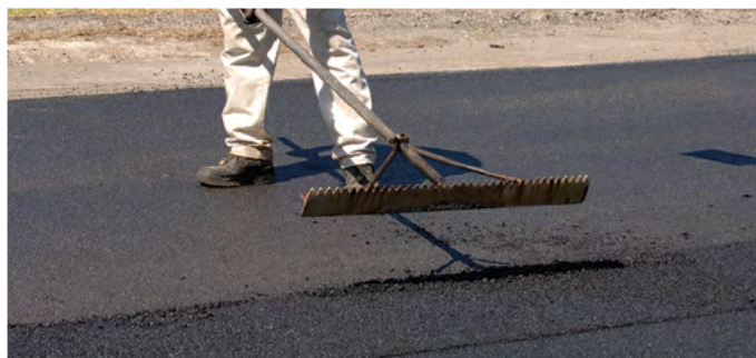
Асфальтобетонная смесь с низким уровнем вязкости, не имеющая запаха, произведенная в установке Green Pac легко укладывается вручную.
